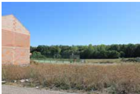
Les 15 maisons de Pré des Seigneurs, 3 seront construites derrière les 17 en cours de construction de Pré des Seigneurs 2 et le city stade.
